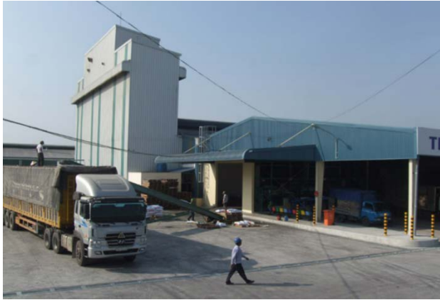
Anova Feed Factory-Phase 2/ Nhà máy Anova feed - Giai đoạn 2
