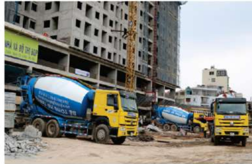
Thi công Tòa nhà Bộ Quốc phòng Construction of Ministry of defense building
