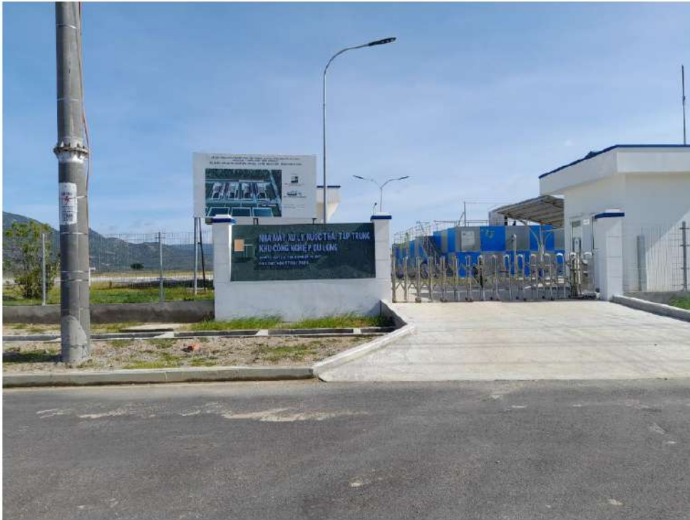
Hình ảnh Nhà máy xử lý nước thải bằng công nghệ SBR, chụp tháng 6 năm 2023
