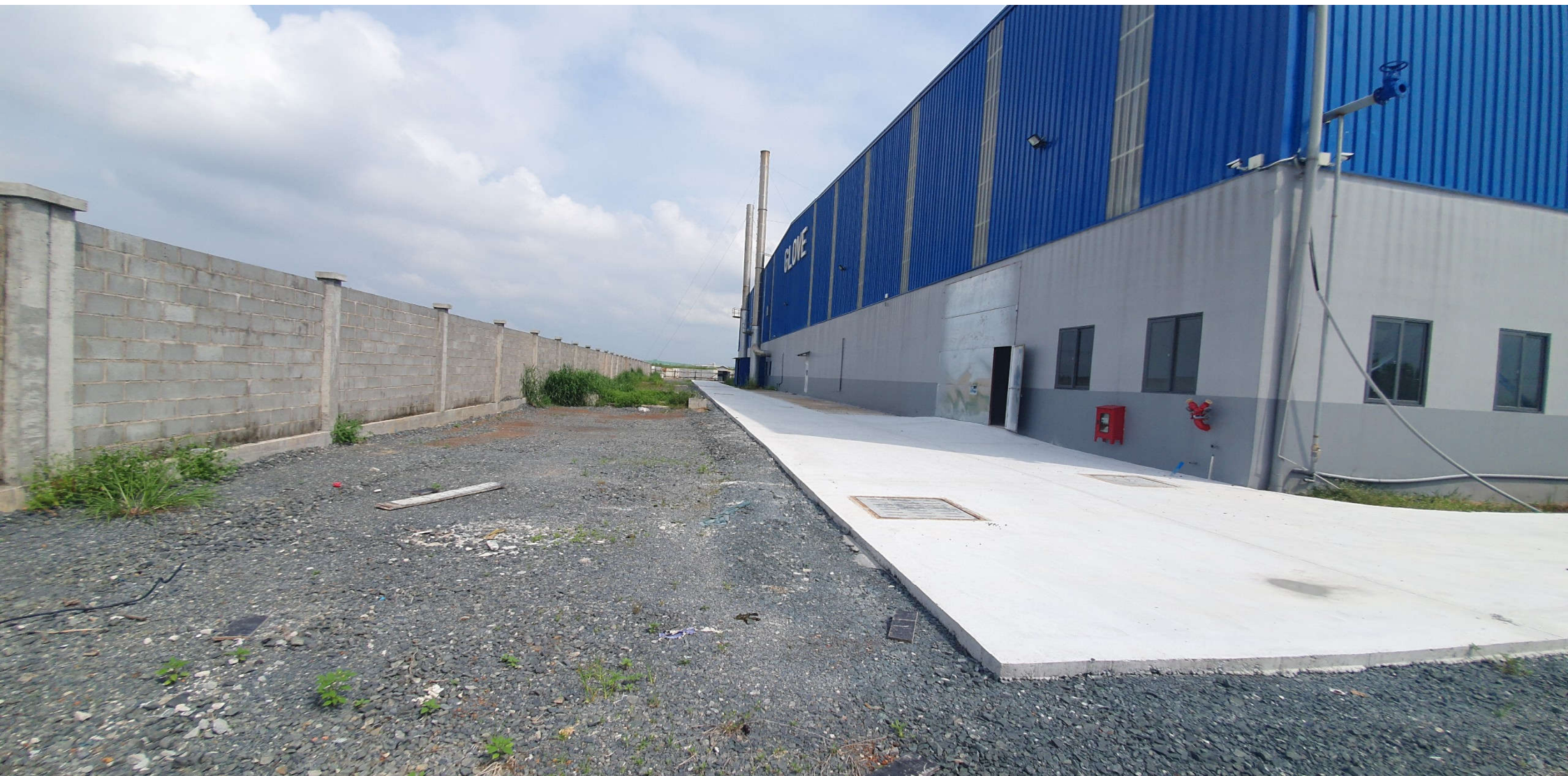
Góc sau nhà xưởng
