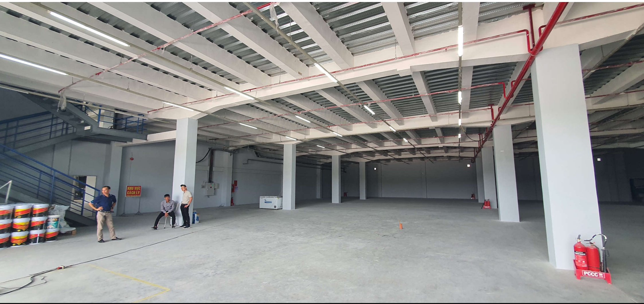
Hệ thống PCCC + điện chiếu sáng đã hoàn thành
