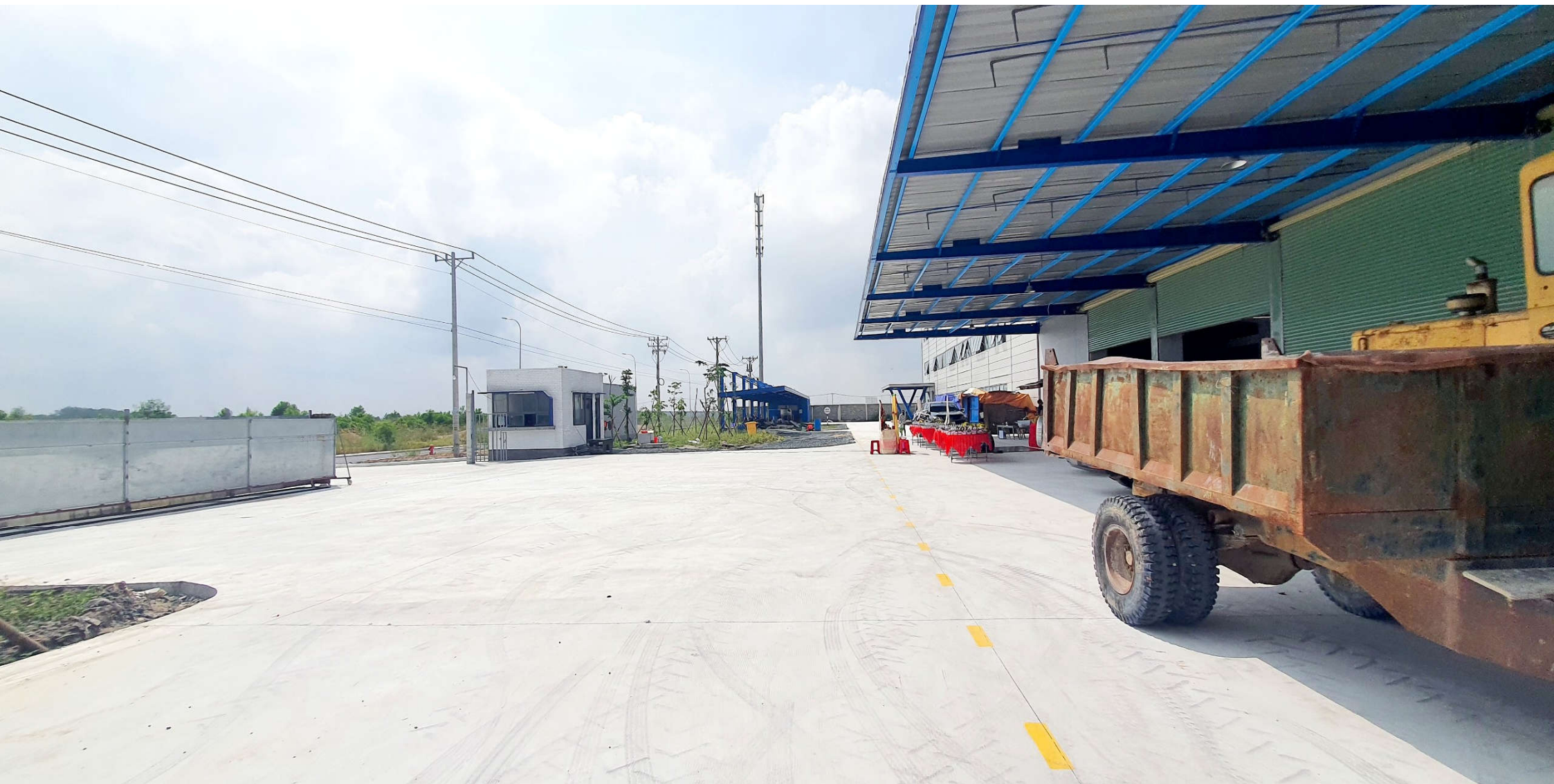
Đường bê tông phía trước
