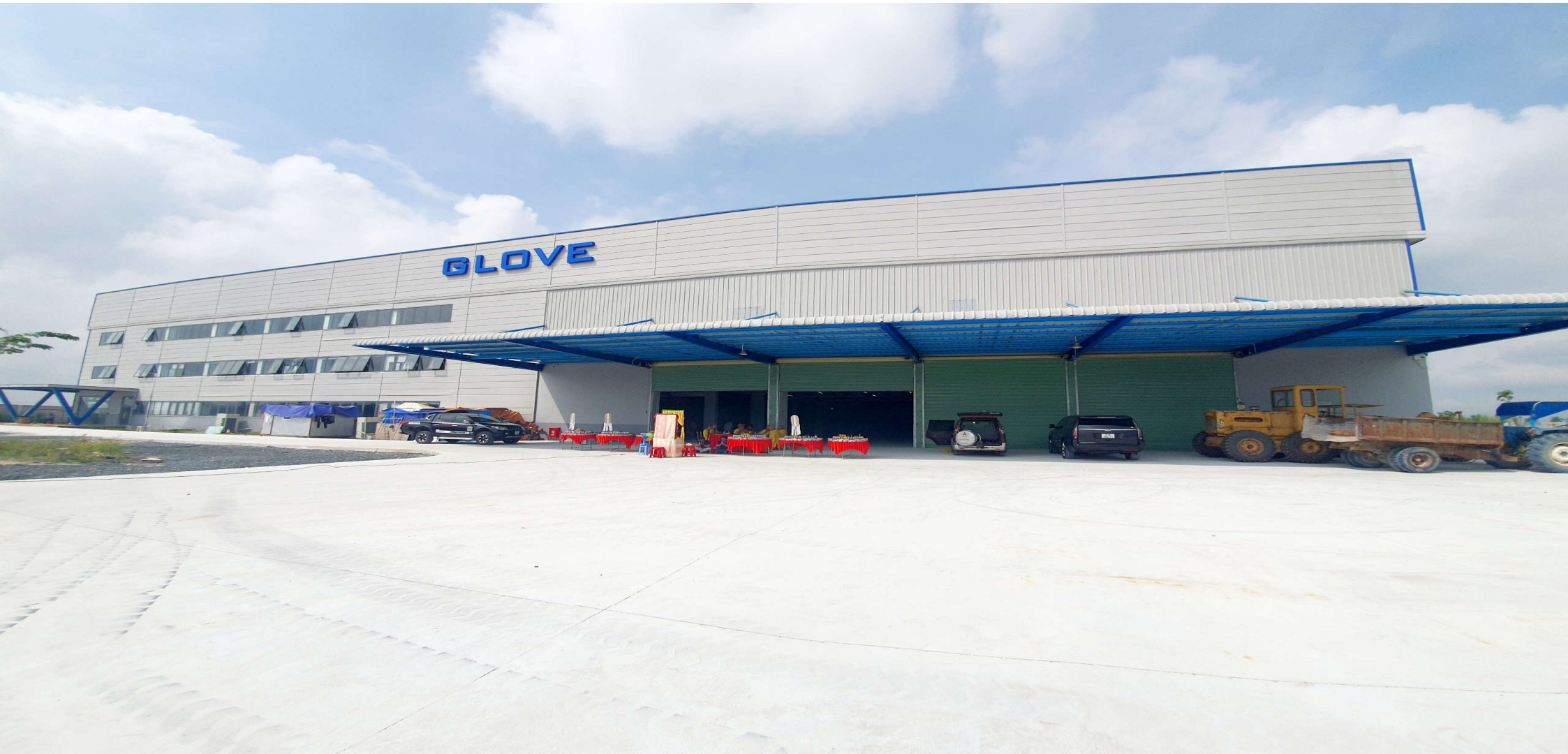
Toàn cảnh phía trước nhà xưởng. Có 4 cửa xuất hàng. Đường phía trước đã hoàn thiện bê tông
