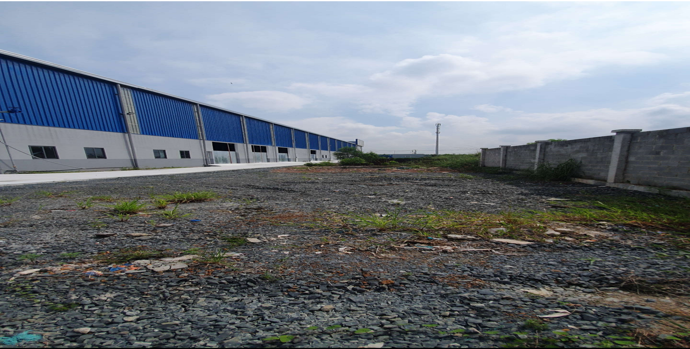
Góc sau nhà xưởng
