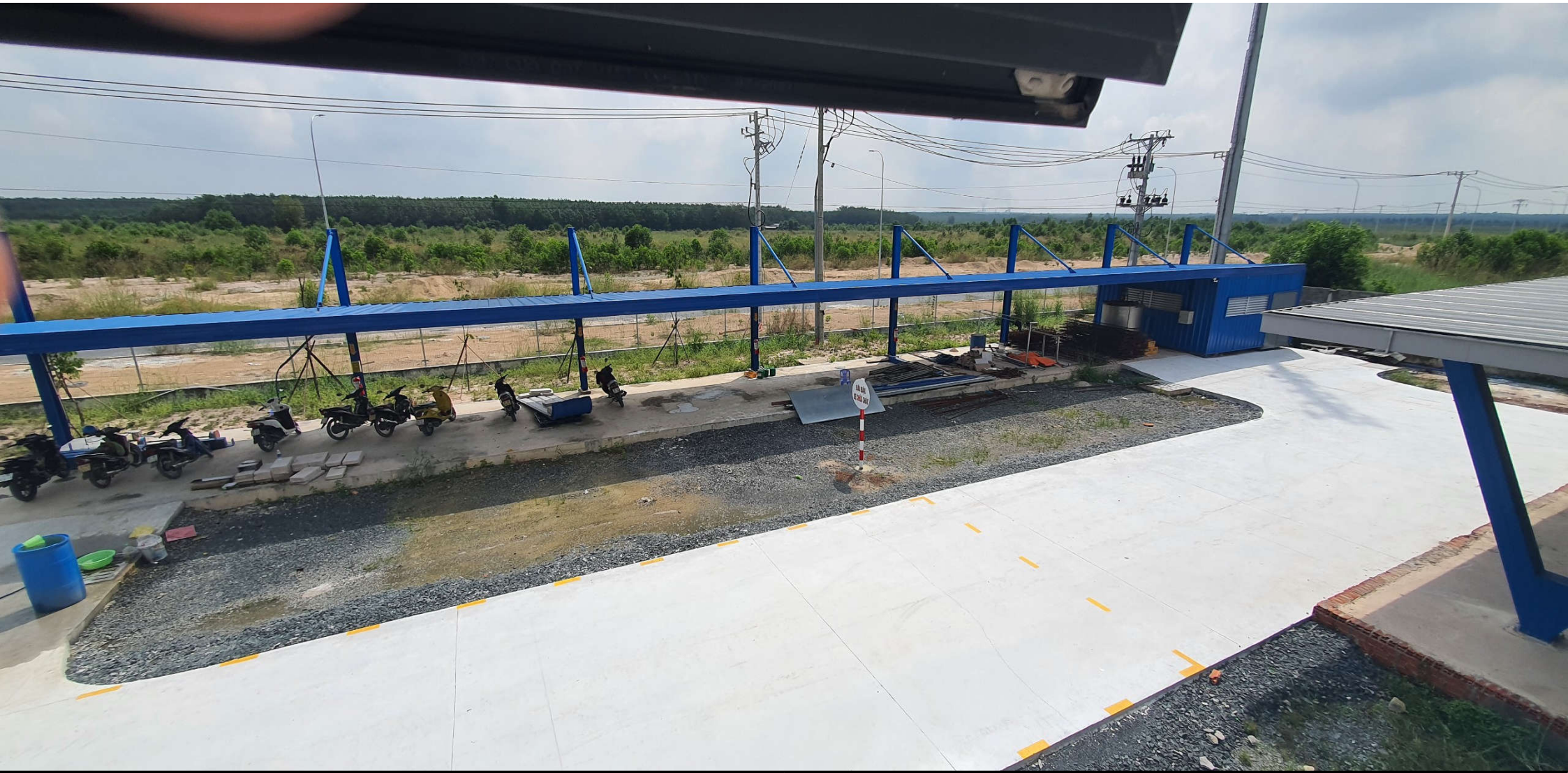
Nhà xe 2 bánh + trạm bơm PCCC
