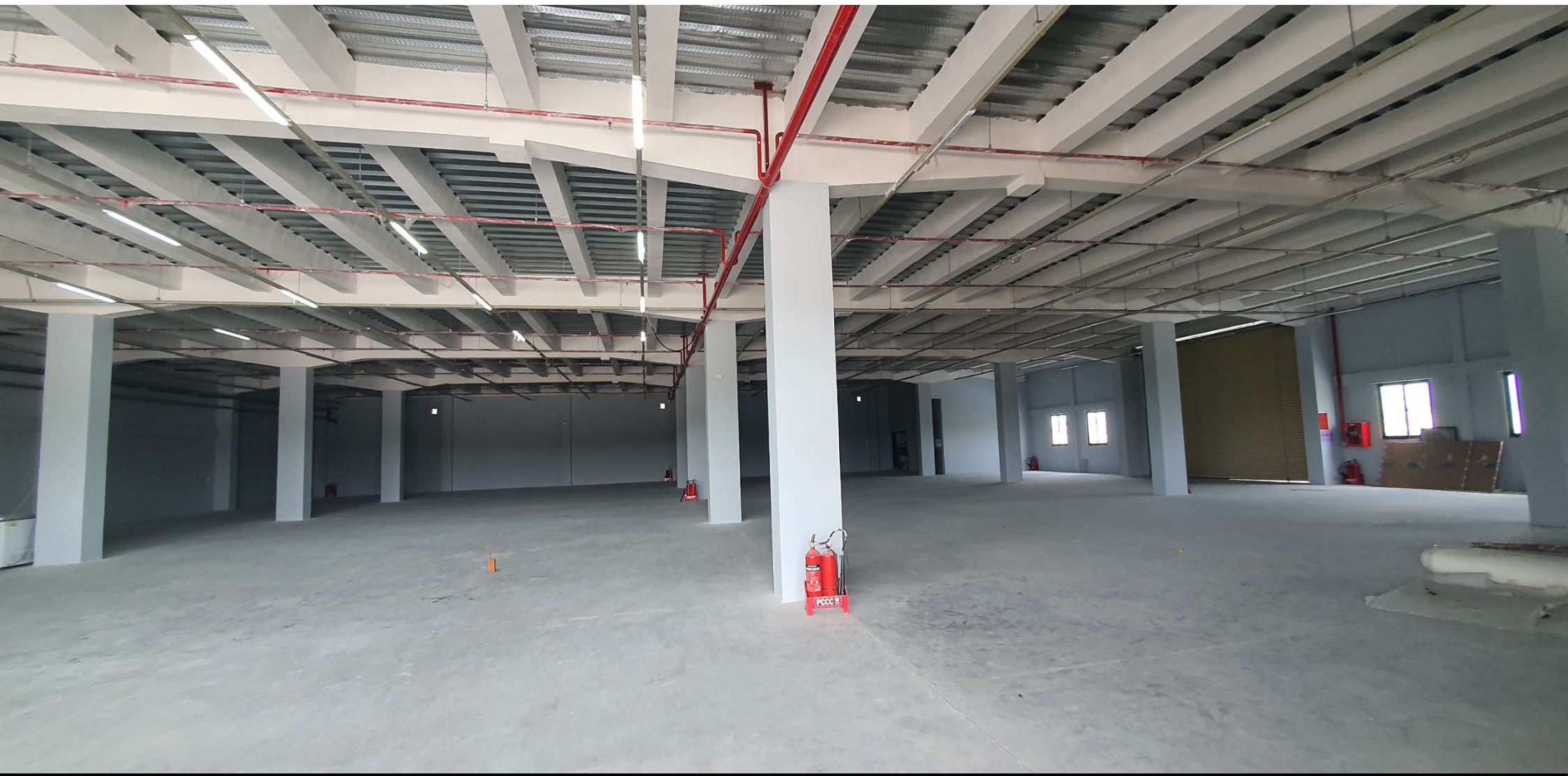
Hệ thống PCCC + điện chiếu sáng đã hoàn thành
