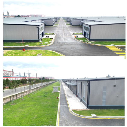
8 Tháng 10 năm 2024 Đường chưa đất tên Bau Bang Bình Dương
